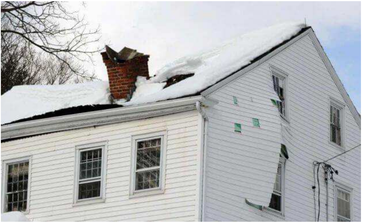
Рисунок 2 – Последствия сильной снеговой нагрузки
