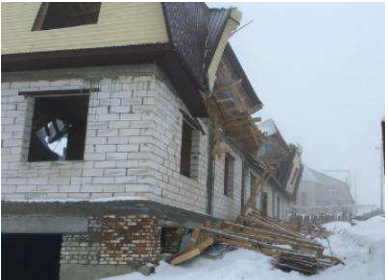
Рисунок 3 – Последствия сильной ветровой нагрузки
