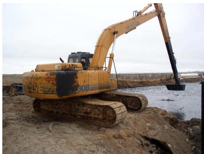
Рисунок 2.5 – Сбор шлама экскаватором из шламового амбара
