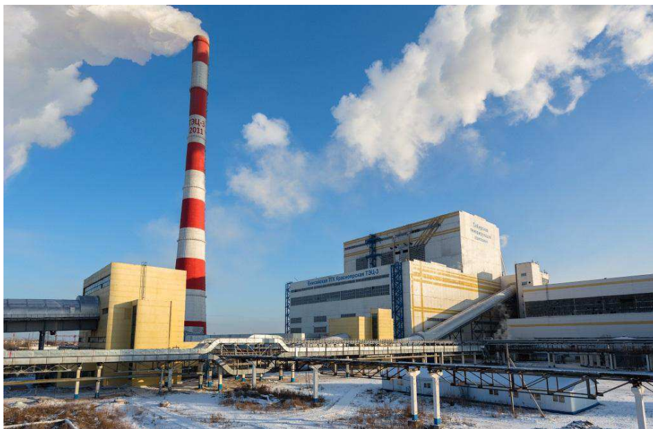
Рисунок 9 – ТЭЦ-3 г. Красноярск
