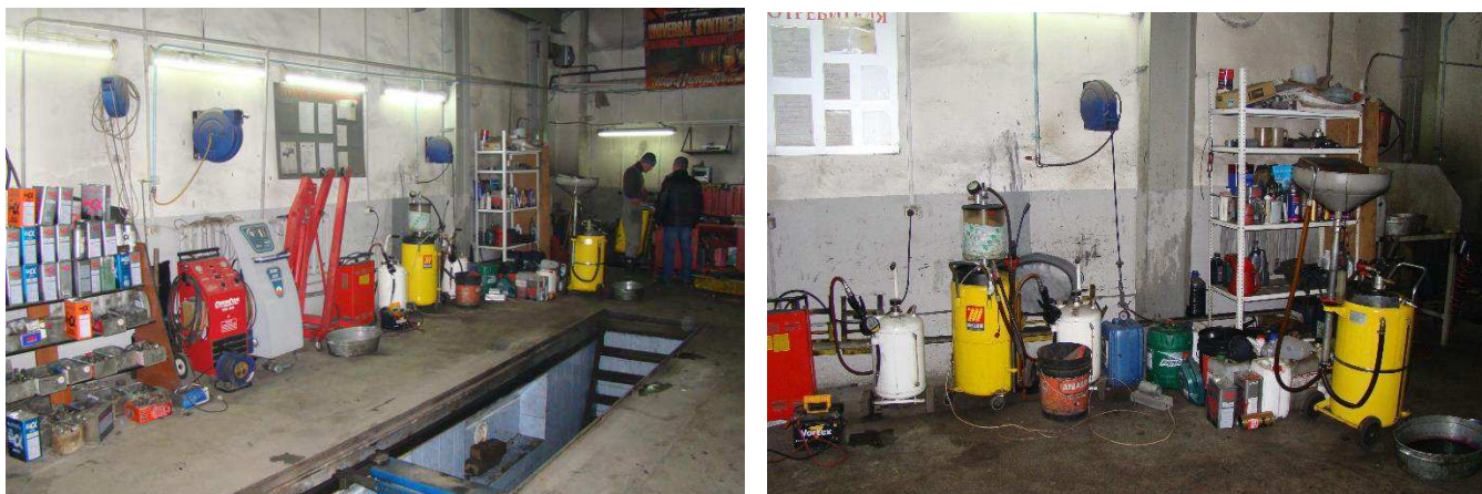
Рисунок 1.2 – Пост ТО, ремонта и замене эксплуатационных жидкостей
