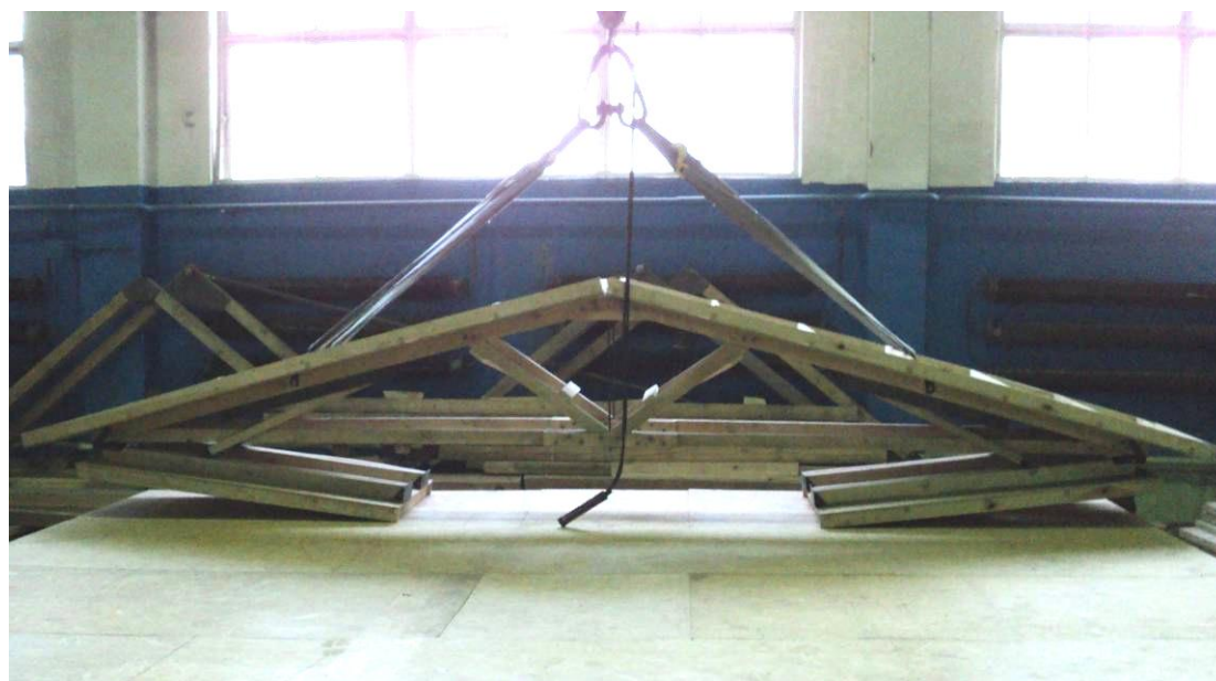
Рисунок 1 - Рамнопанельная блок-секция (в процессе монтажа)
