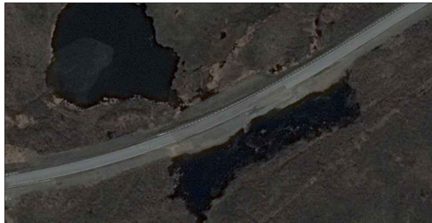
Рис. 3 - Фильтрация воды через насыпь (фото со спутника)
