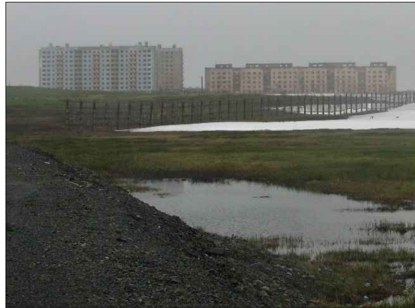
Рис. 1 - Образование термокарстовых озер у подошвы насыпи
