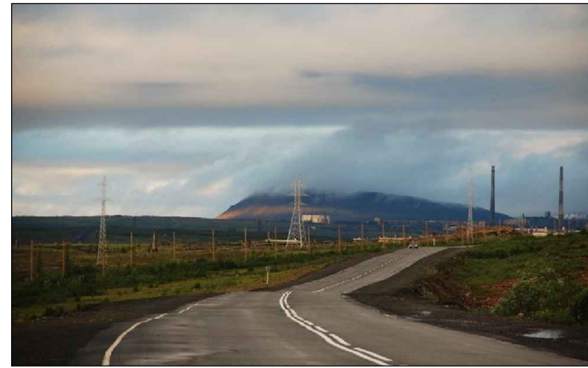
Рис. 4 - Незатухающая термопросадка насыпи
