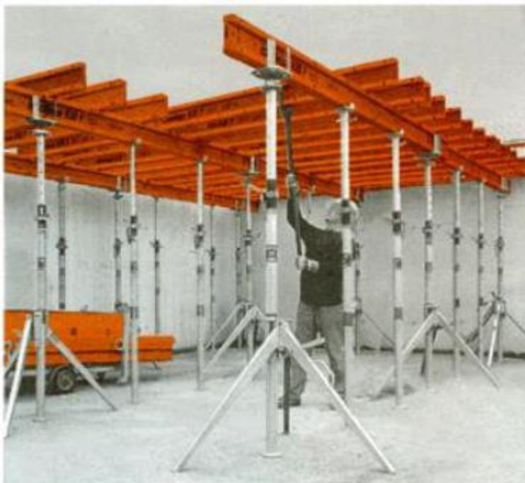
Рисунок 3.3 – Укладка распределительных балок
