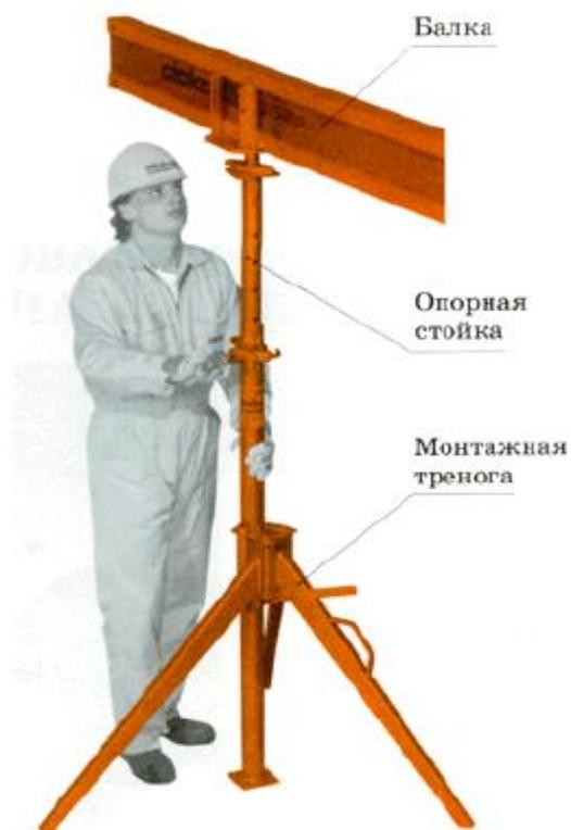
Рисунок 3.4 – Выверка положения стоек по высоте
