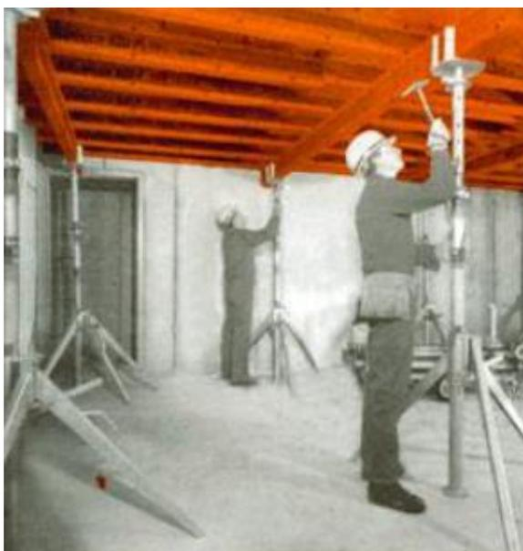
Рисунок 3.6 – опускание продольной балки
