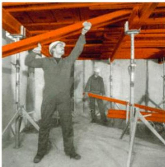
Рисунок 3.7 – Снятие поперечных балок
