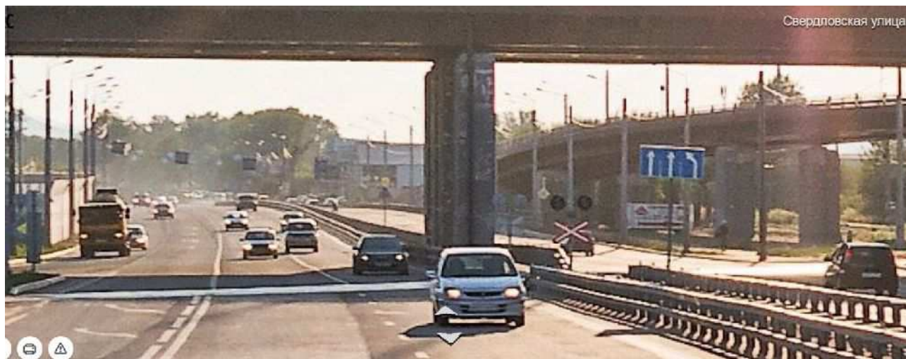
Рисунок 11 – Вид на эстакаду многоуровневой развязки на пересечении ул. Свердловская и дорогой на Новый мост
