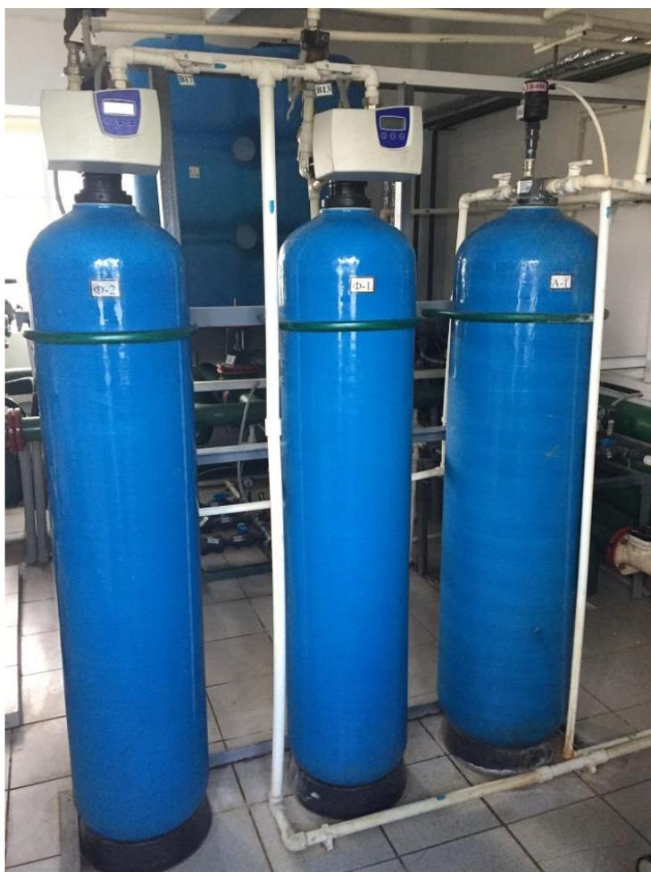
Рисунок 13 – Установка аэрационной обработки воды напорным методом на Пойменской НПС.
