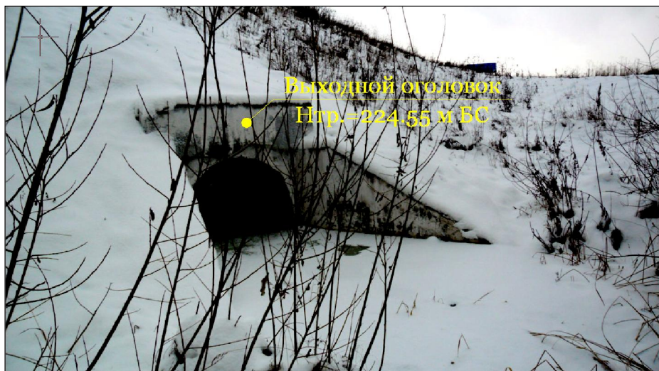
Фото 3. Выходной оголовок с наледью, скопившейся перед запрудой
