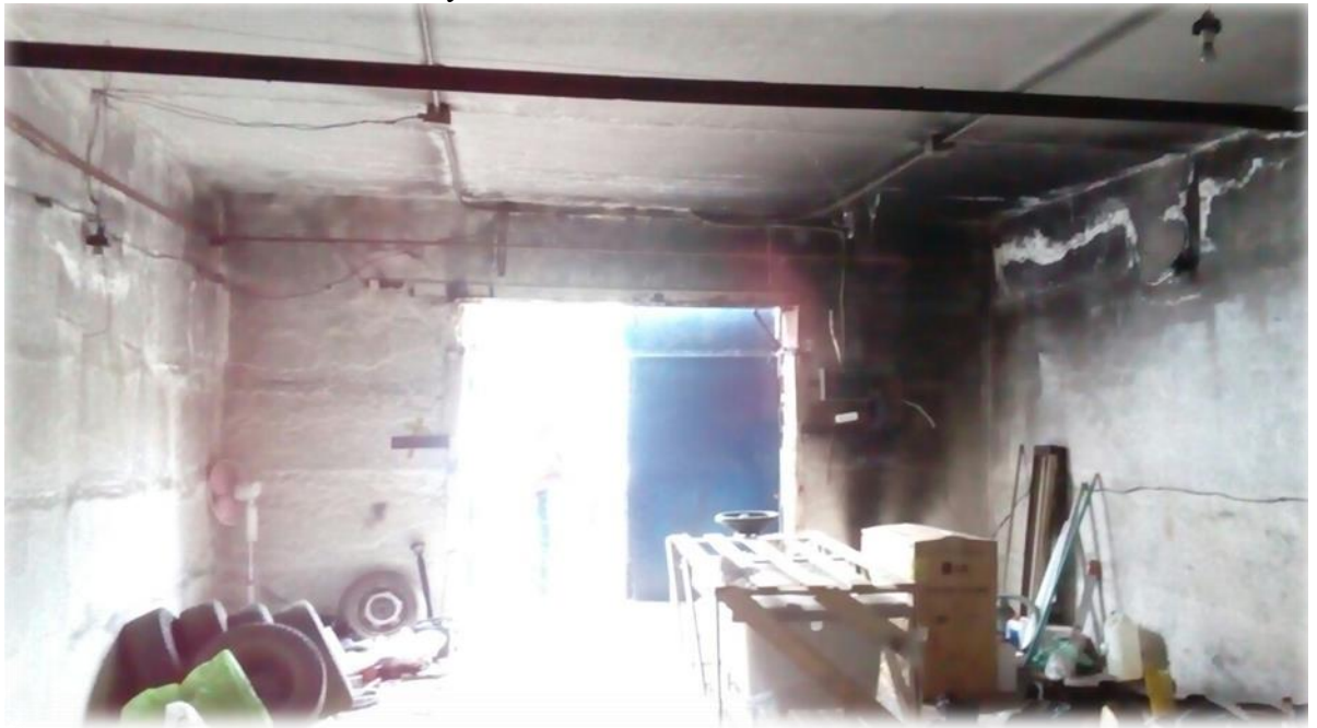
Рисунок 33 - Помещение в осях 3-4
