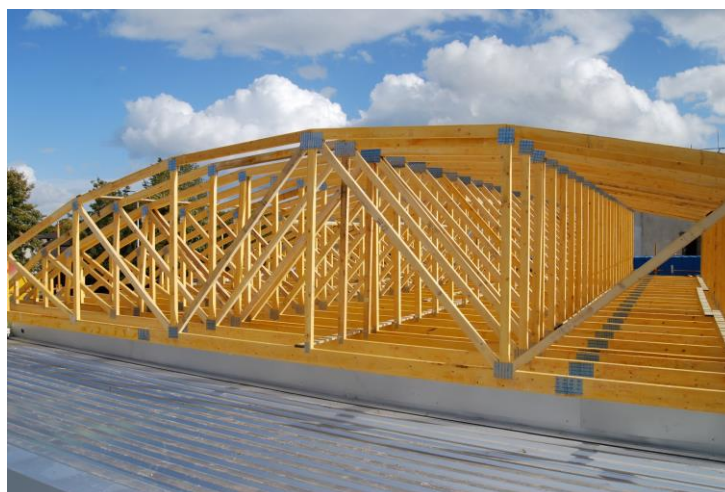
Рисунок 9 – Арочная стропильная конструкция
