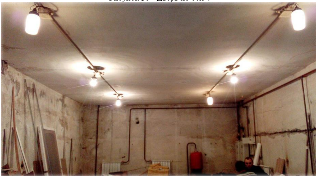
Рисунок 31 - Помещение в осях 3-4
