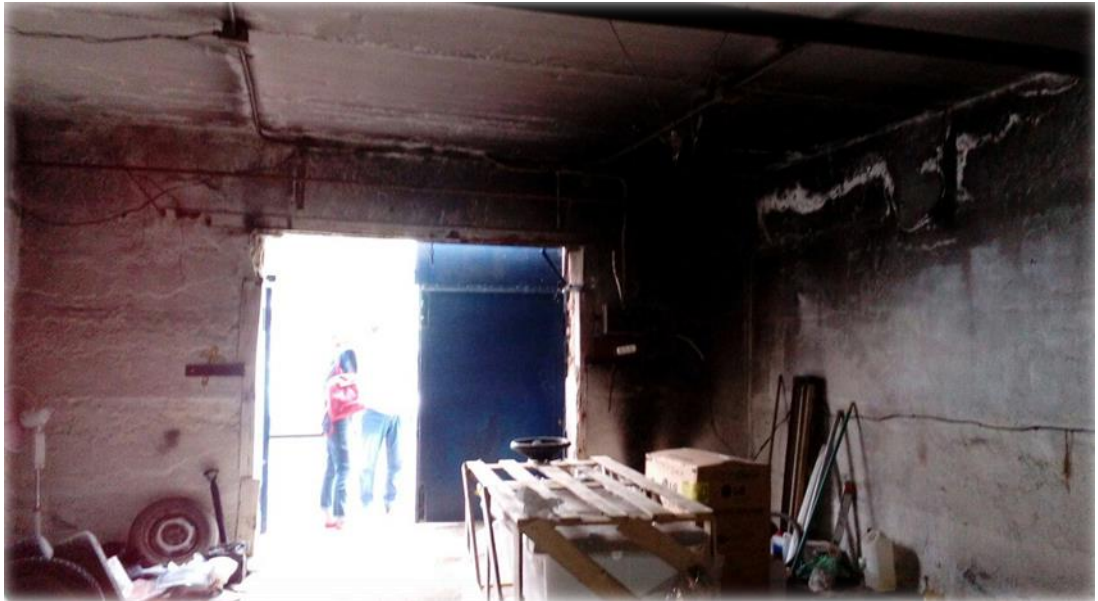
Рисунок 27 - Помещение в осях 5-6
