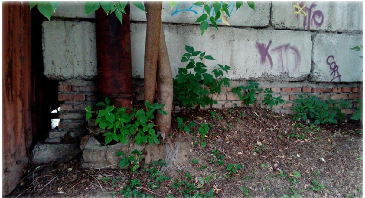
Рисунок 35 - Вид части здания в осях 6-1
