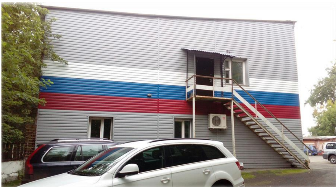
Рисунок 23 - Вид части здания в осях Б-А с торца
