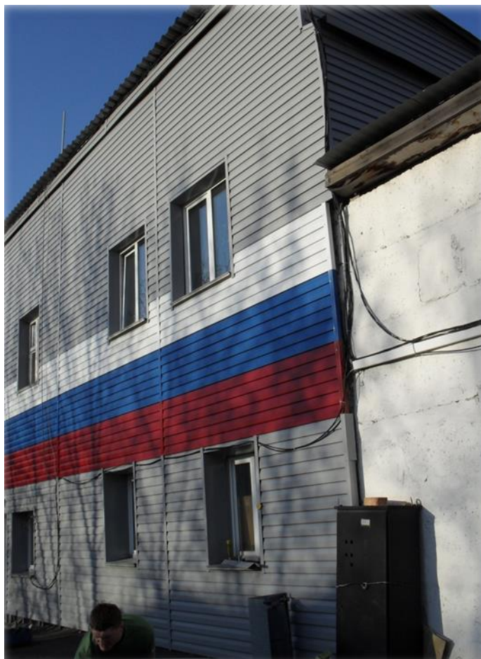
Рисунок 20 - Вид части здания в осях 1-3
