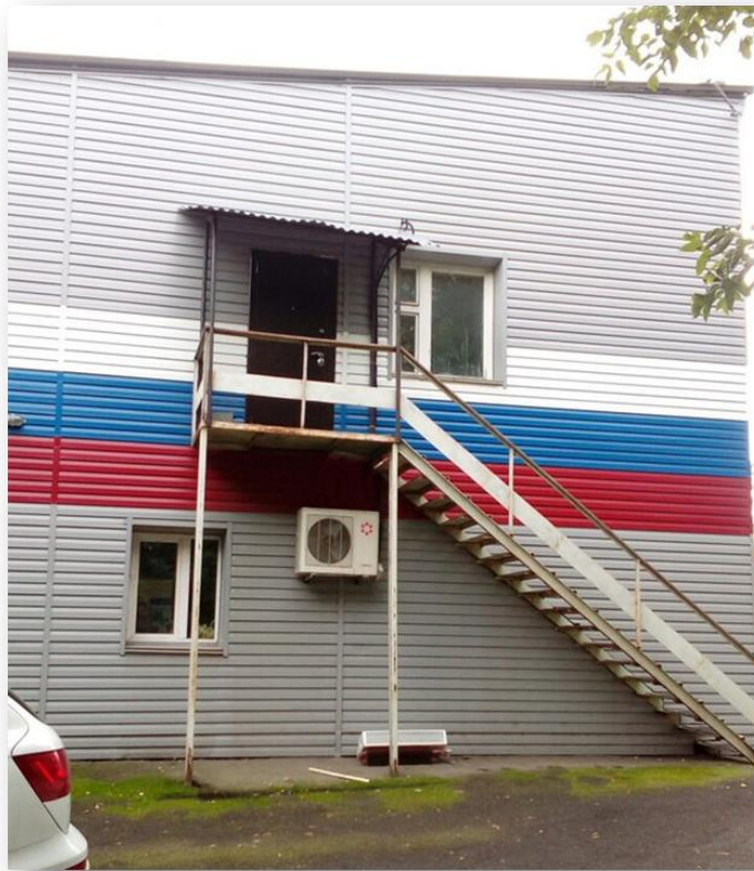
Рисунок 2 - Лестница на второй этаж
