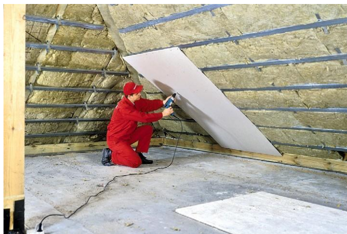
Рисунок 7 - Устройство утеплителя из минеральной ваты, отделка гипсокартонном.
