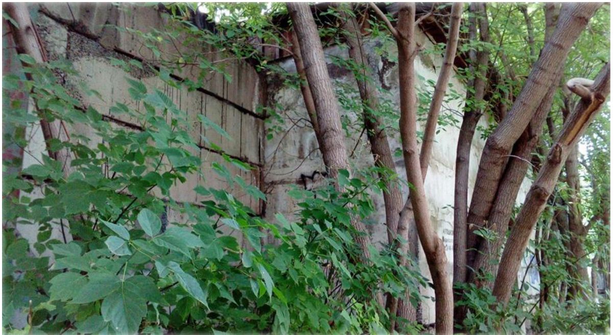
Рисунок 34 - Вид части здания в осях 6-1
