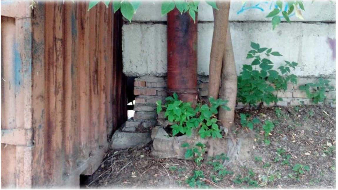
Рисунок 36 - Вид части здания в осях 6-1
