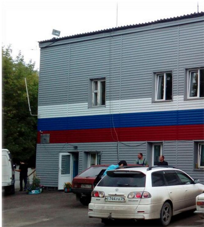
Рисунок 22 - Вид части здания в осях 1-3
