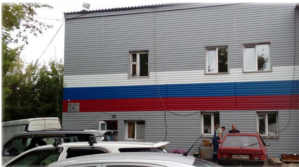
Рисунок 21 - Вид части здания в осях 1-3
