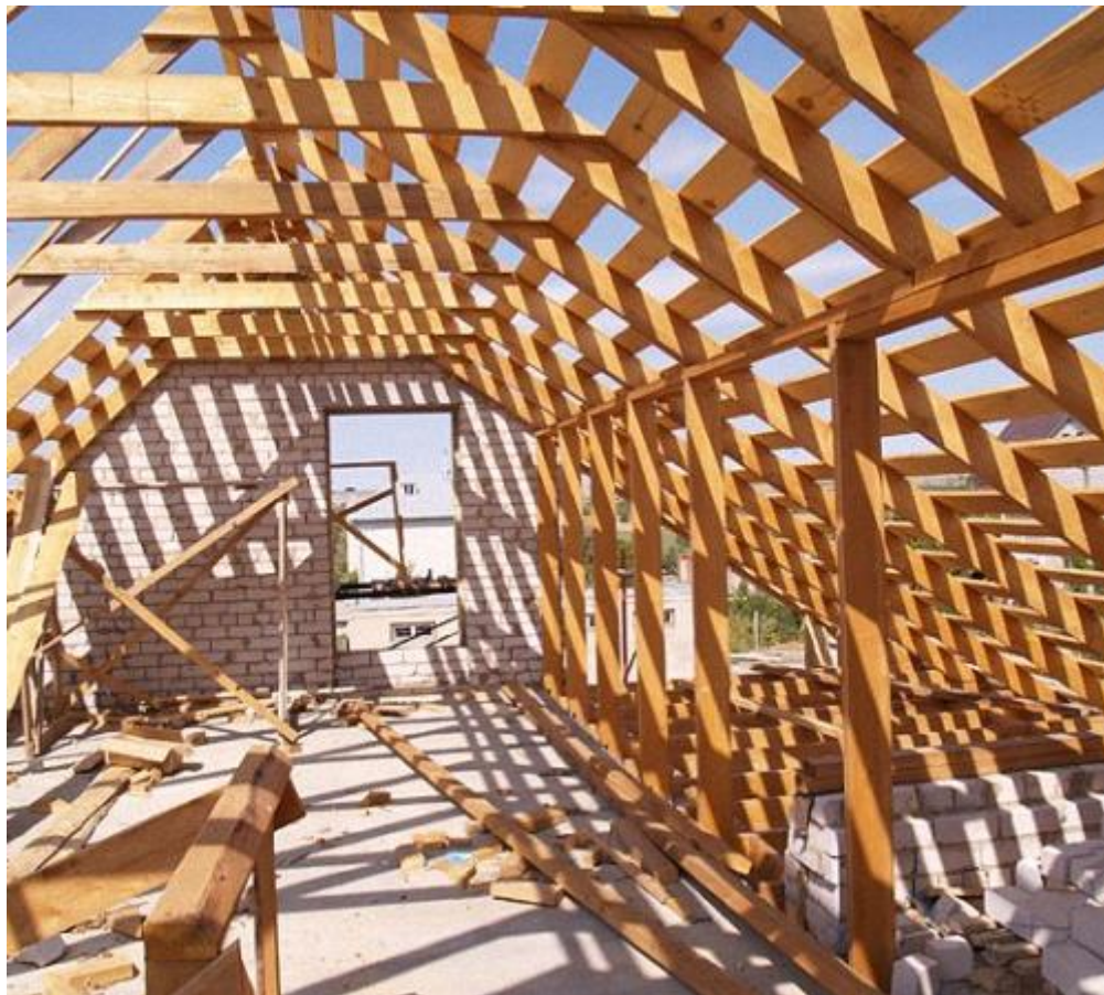
Рис. 1 Устройство стропильного каркаса мансардного этажа.
