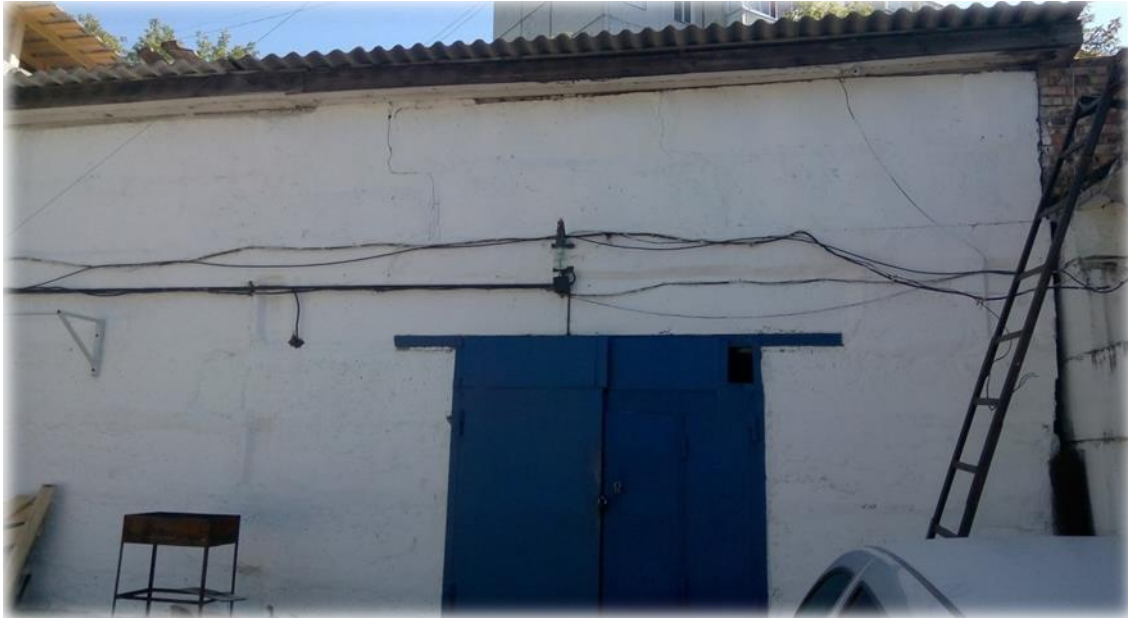
Рисунок 26 - Вид части здания в осях 3-6
