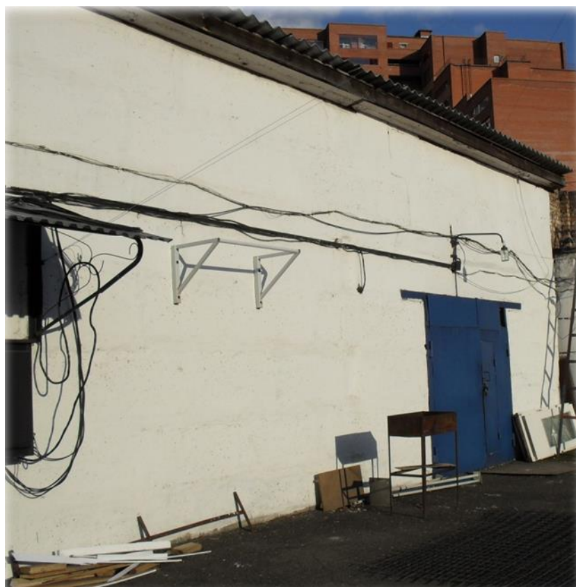
Рисунок 25 - Вид части здания в осях 3-б
