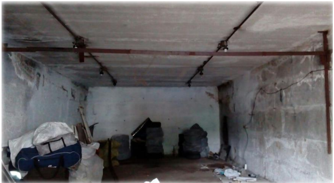
Рисунок 29 - Помещение в осях 5-6
