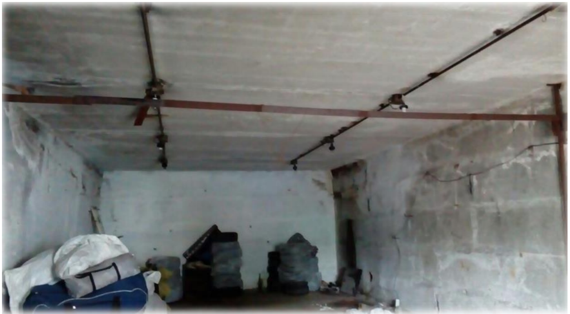
Рисунок 28 - Помещение в осях 5-6
