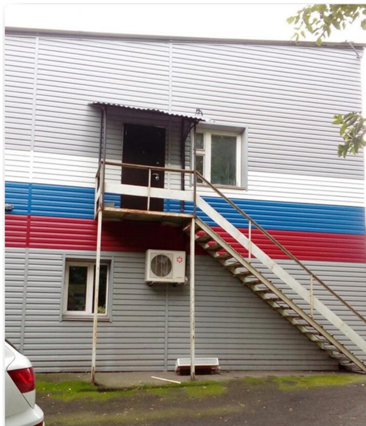
Рисунок 24 - Вид части здания в осях Б-А с торца
