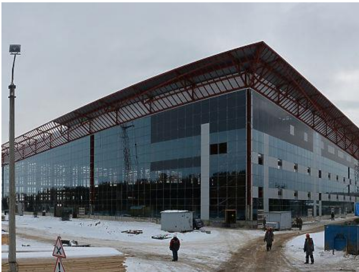
Рисунок 1.2 – Строящийся терминал нового аэровокзала
