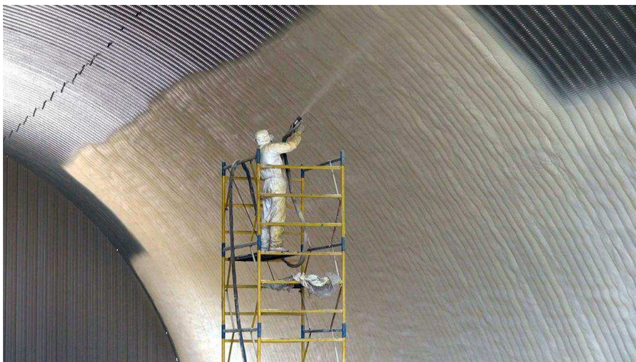
Рисунок 13 – Утепление пенополиуретаном ангара
