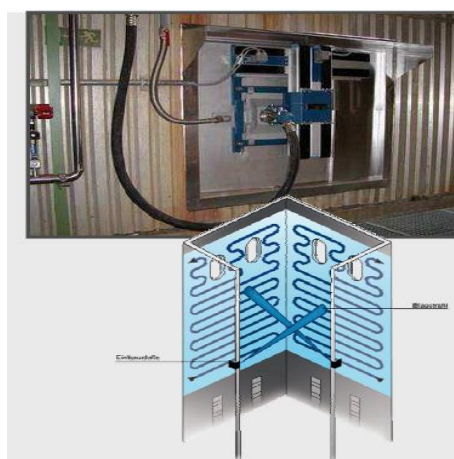
Рисунок 95 - Аппарат водяной обдувки и схема его работы
