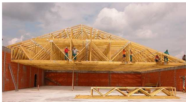
Fig. 2.- Cerchas en tijera, en edificio comercial. Washington (EEUU).
