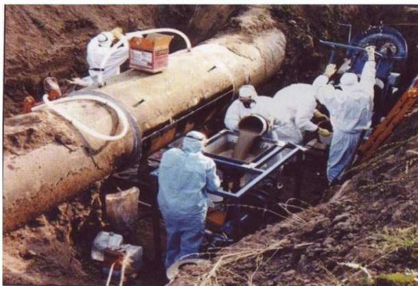
Рисунок 3.9 - Заполнение муфты П1герметиком
