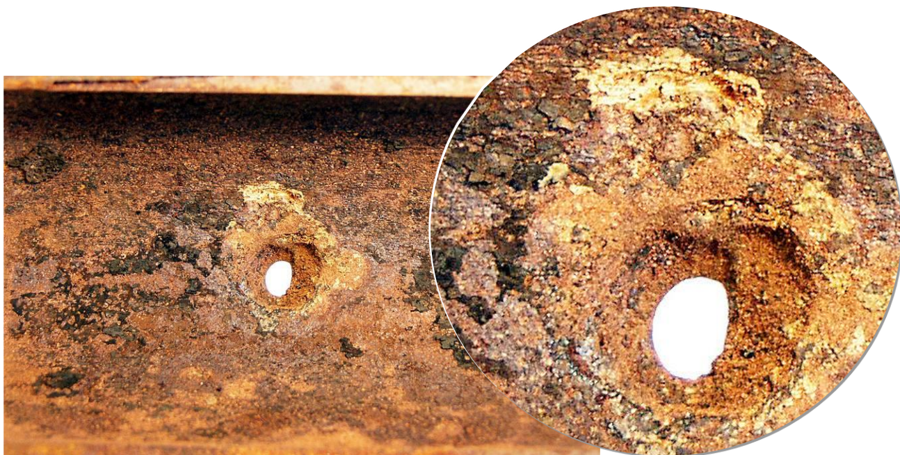
Рисунок 5 – НКТ наработка 327 суток. Коррозионно-активная скважина.
