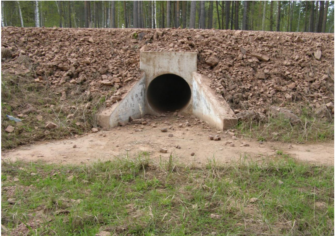
Рис.3 - труба на ПК33+70
