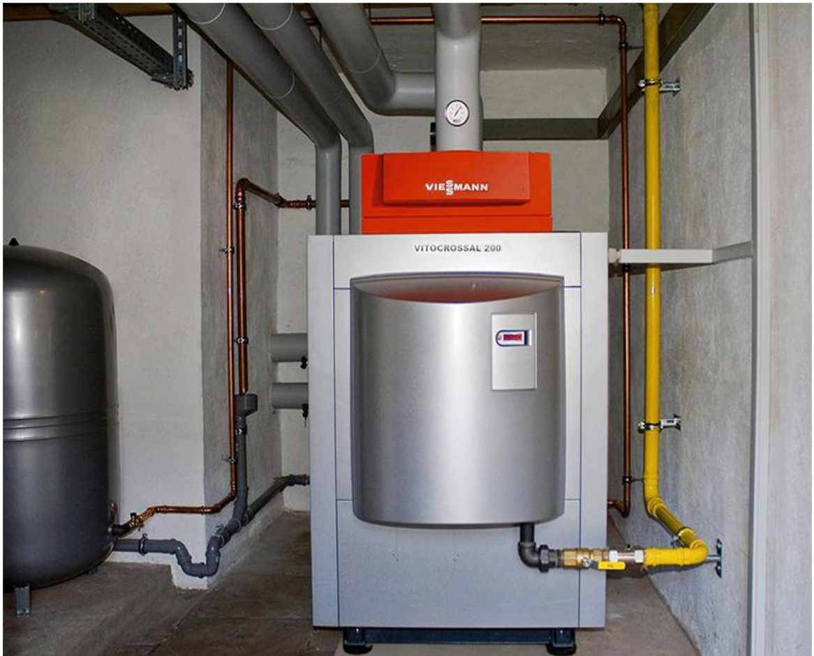
Рисунок 3 – Установка для газового отопления
