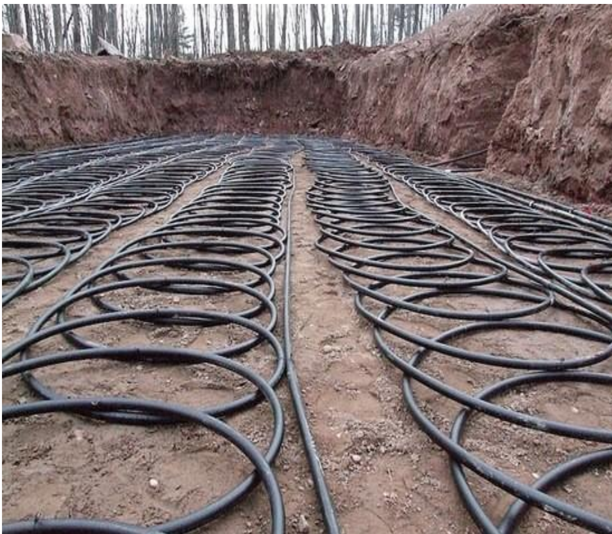
Рисунок 7 – Укладка контура кольцево параллельным способом
