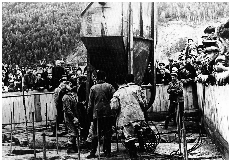
10 августа 1961 г. Первый бетон в основание плотины
