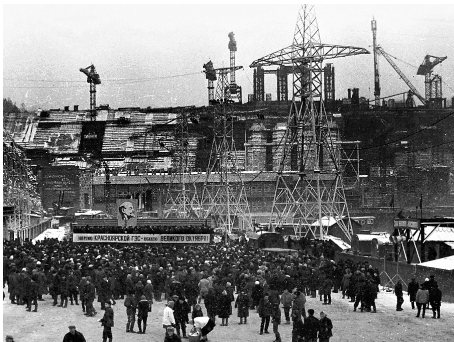
Ноябрь 1967 г. Пуск первого гидроагрегата
