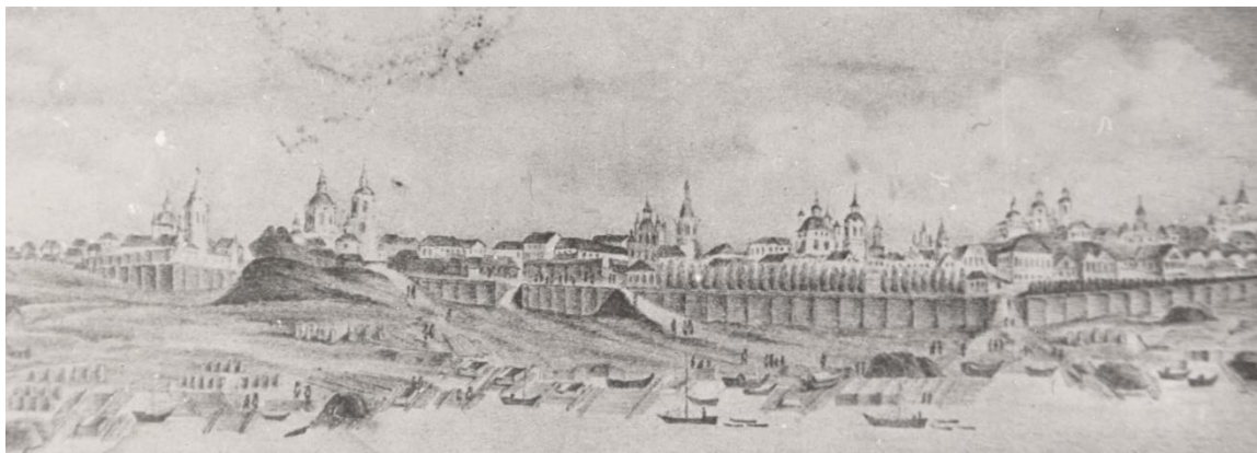
Вид западной Нагорной части города – центра духовной культуры и острога с историей в четыре столетия в речной панораме (на акварели начала XIX века – город как путешествие в прошлое)
