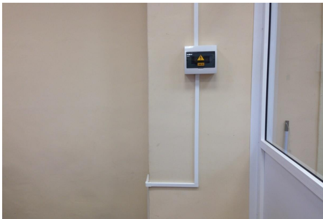
Рисунок 2.3 – Кабель-канал 16x25 в лаборатории по курсу электробезопасность.
