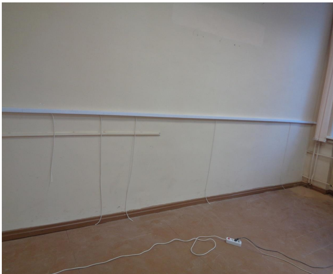
Рисунок 2.2 - Кабель-канал 40x40 в лаборатории по курсу релейная защита
