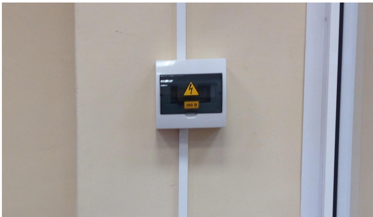
Рисунок 2.11 – Внешний вид распределительного щита в лаборатории по курсу «Средства и системы обеспечения электробезопасности на горных предприятиях»
