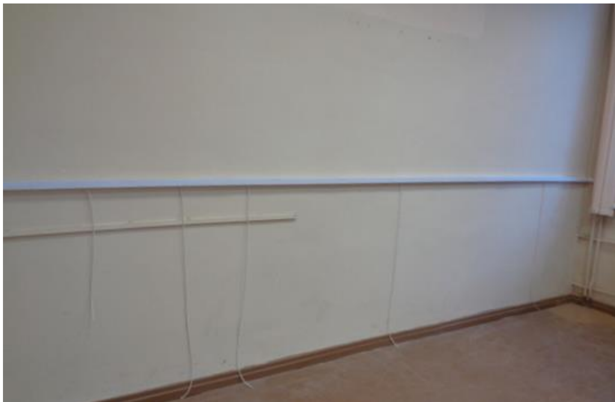
Рисунок 2.7 – Кабель – канал 40x40 в лаборатории по курсу «Релейная защита»
