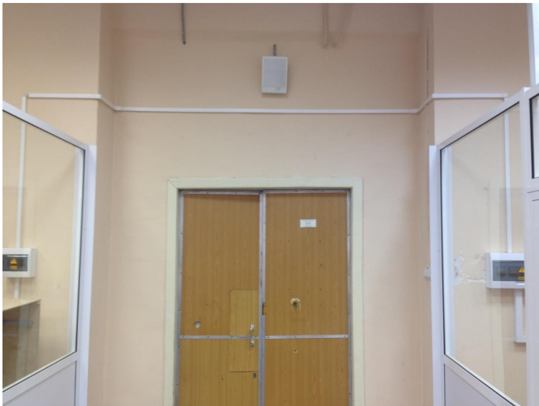
Рисунок 2.8 – Кабель–канал 16x25 в лаборатории по курсу «Средства и системы обеспечения электробезопасности на горных предприятиях»
