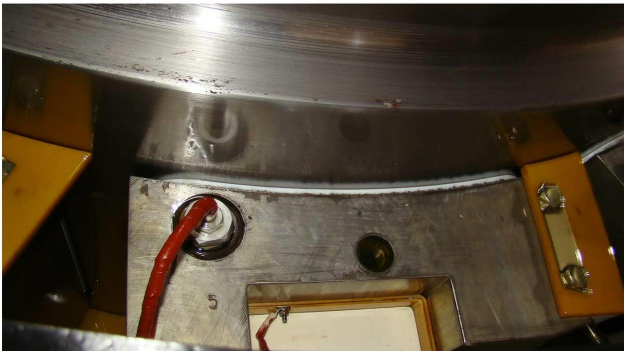
Рисунок 9.2- Датчик ТК в сегменте подшипника
