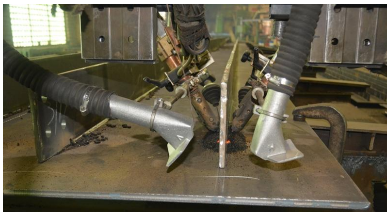
Рисунок 2.4 – Сварка ребер жесткости ортотропных плит
