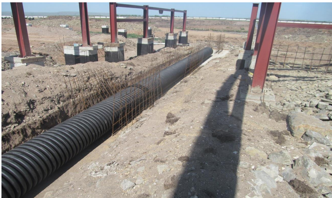
Рисунок 6.1 Канал навозаудаления
