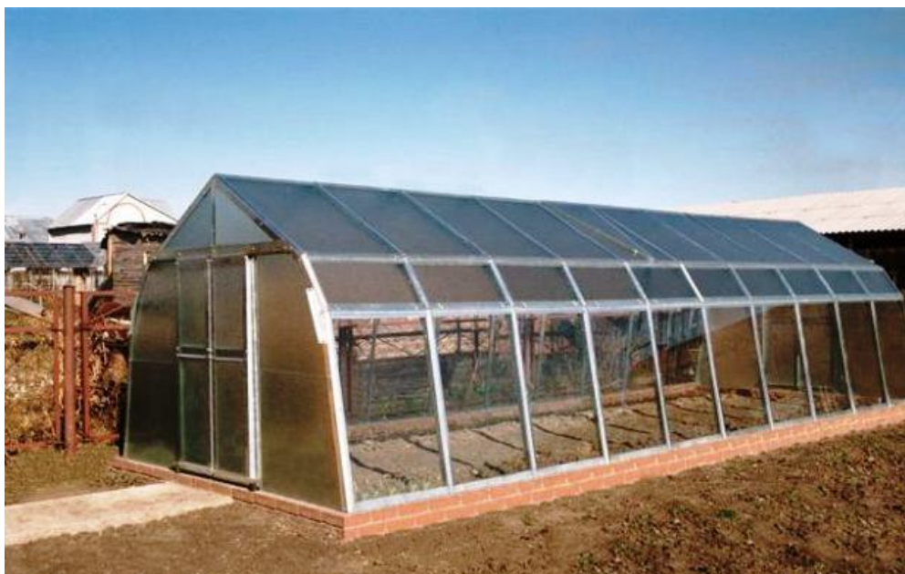
Рисунок 2.6 – Теплица с наклонными стенками
