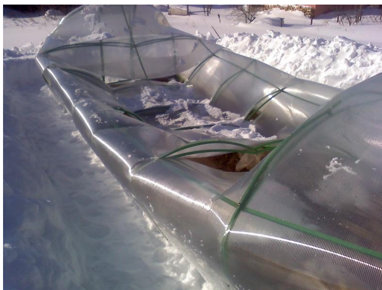
Рисунок 1.1 – Последствия сильной снеговой нагрузки
