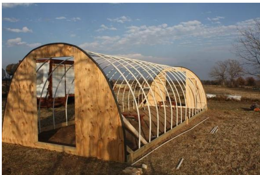
Рисунок 2.3 – Теплица с каркасом из пластиковых труб
