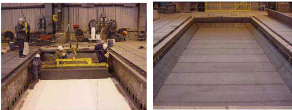
Рисунок 14 – Монтаж футеровки электролизера
