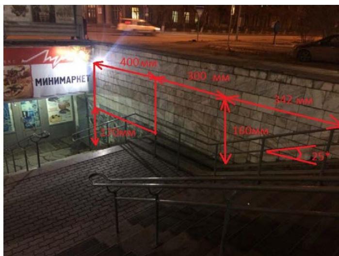
Рис.6 - Замеры лестничного пролета
