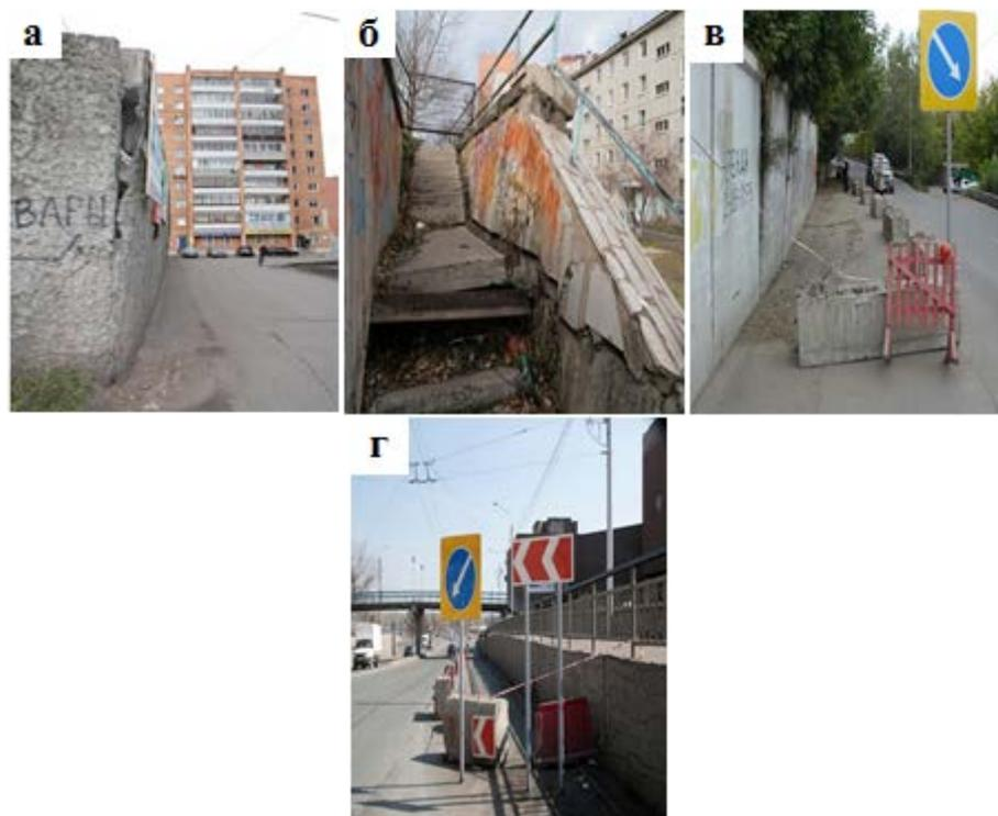
**Рис. 3 – Подпорные стены, находящиеся в аварийном состоянии: а) ул. Петра Словова, 4; б) ул. Гусарова, 14; в) пер. Боготольский, 6; г) ул. Карла Маркса, 6**
