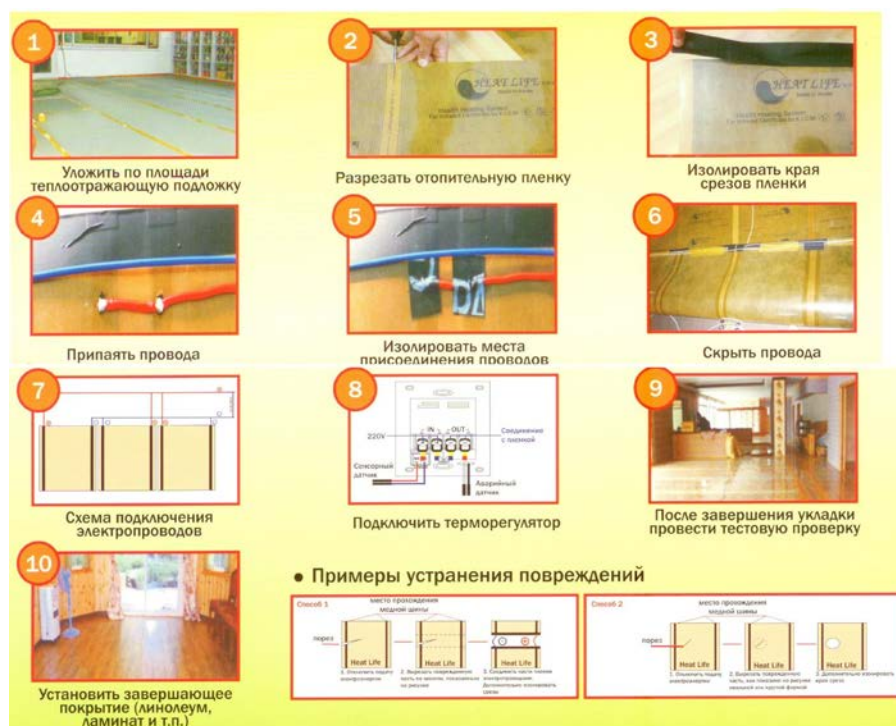
Рис.3 – Порядок монтажа инфракрасной пленки
