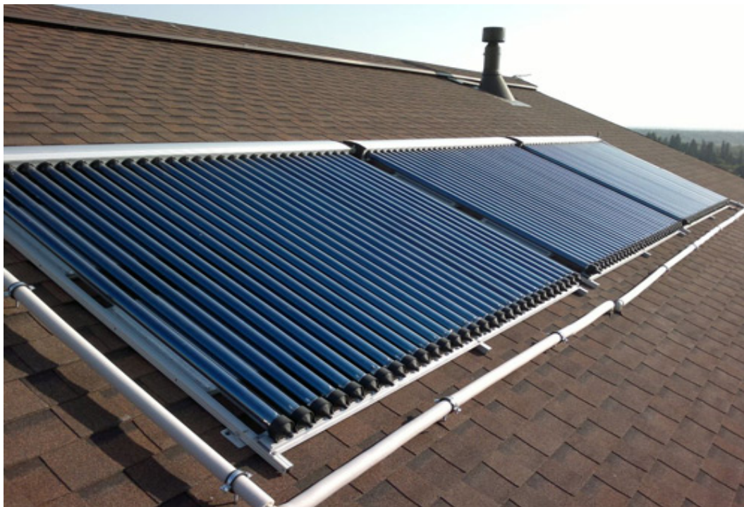
Рис.2 – Установка солнечных коллекторов на крыше дома
