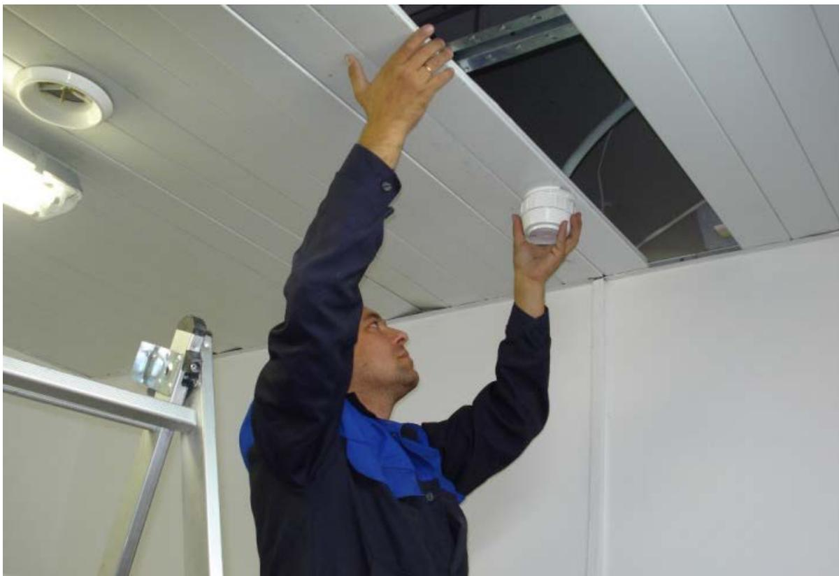
*Рис. 3. Монтаж проводной системы пожарной*
