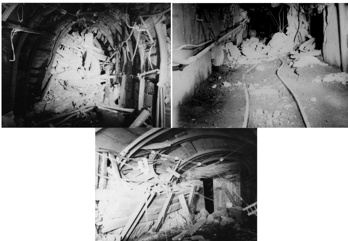
*Рис. 2. Породный завал и искривление путей на Таштагольском руднике*
