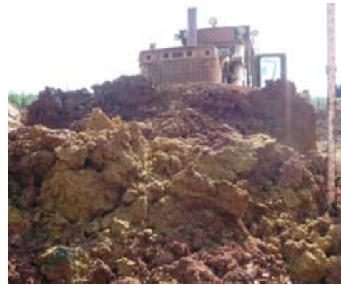
Рис. 1. Отвал глинистых песков после выемки бульдозером Komatsu D355A
