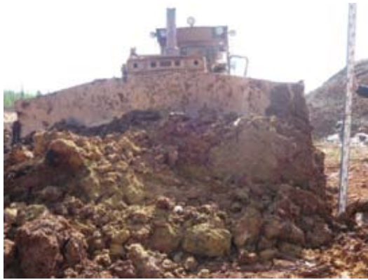
Рис. 1. Отвал глинистых песков после выемки бульдозером Komatsu D355A
