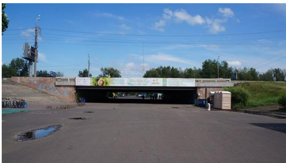
Рисунок 2.10 – Вид вело-пешеходного тоннеля под Октябрьским мостом
