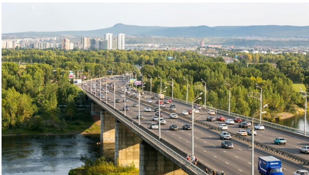
Рисунок 1.7 – Вид Октябрьского моста
