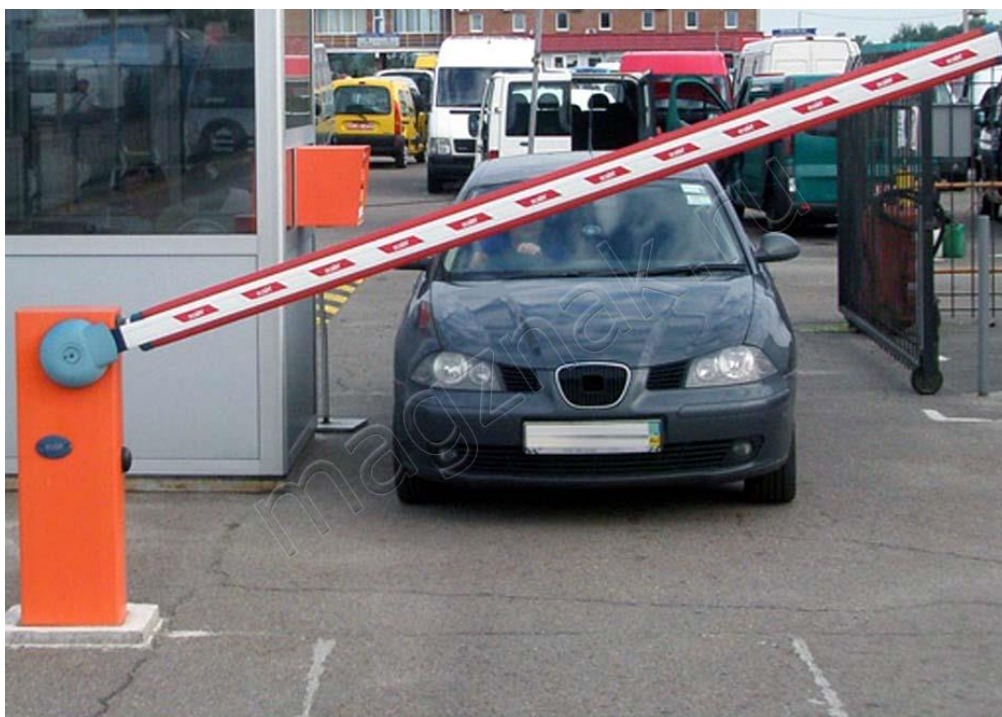
Рисунок 9.1– Полуавтоматическая система парковки с въездной стойкой
