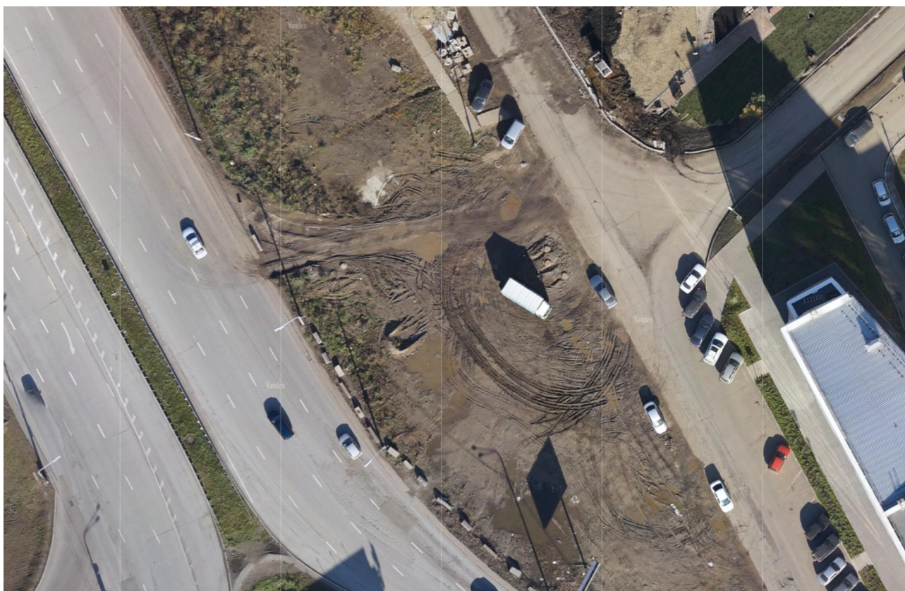
Рисунок 1.26 – Вид несанкционированного выезда на улицу Авиаторов
