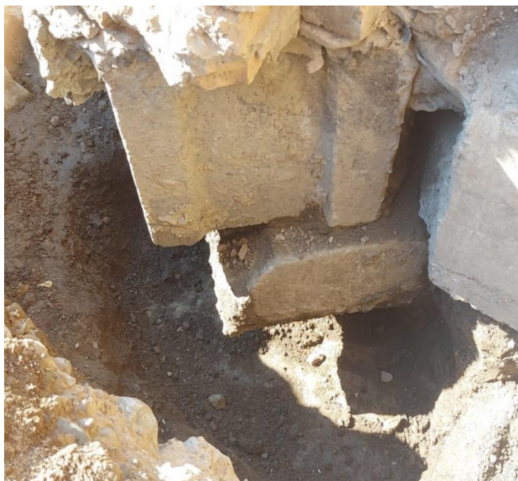
Рис. 3.2.2 - После обнажения подошвы деформированного фундамента
