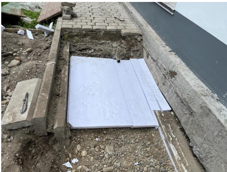
Рис 3.2.6 - Утепление фундамента
