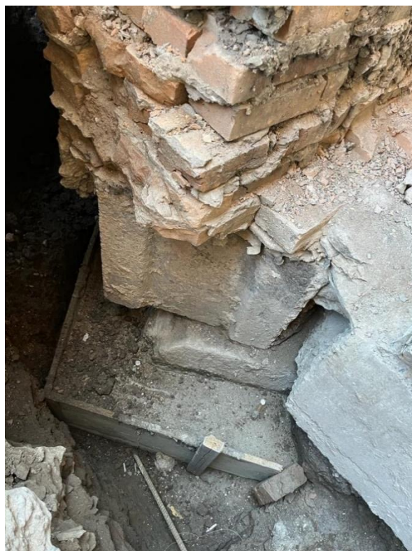
Рис. 3.2.4 - Усиление фундамента
