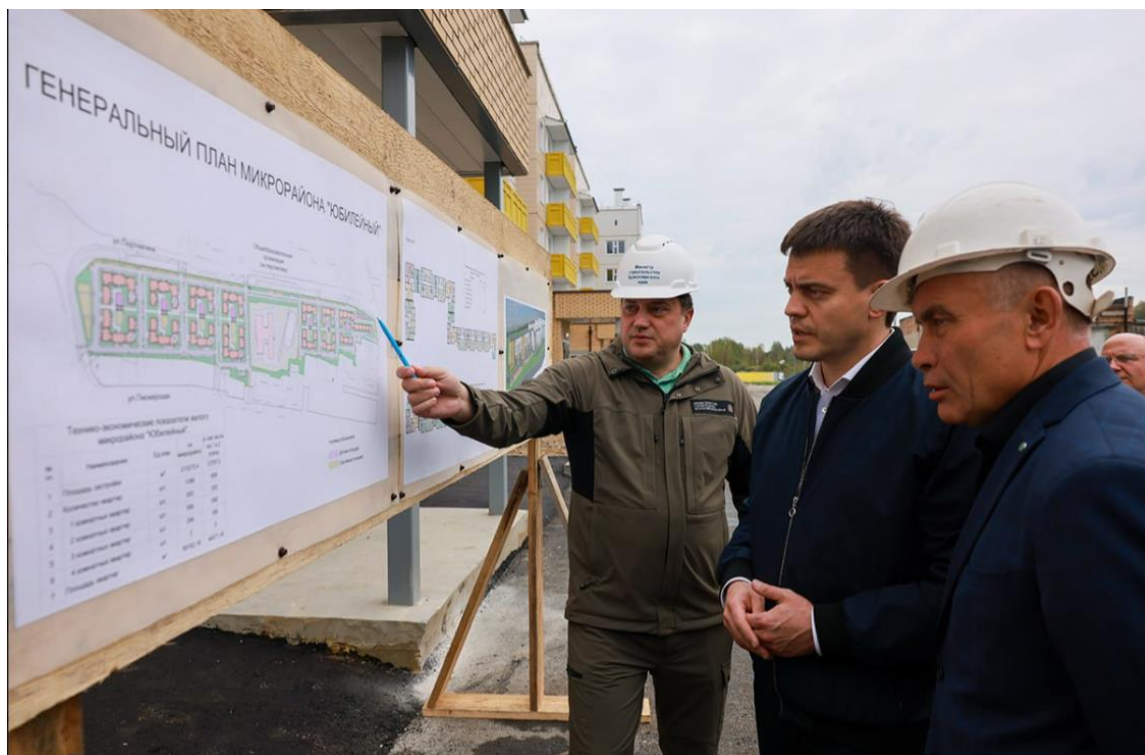
Рисунок 20 – Михаил Котюков во время рабочей поездки в Лесосибирск с целью контроля строительства микрорайона «Юбилейный»
