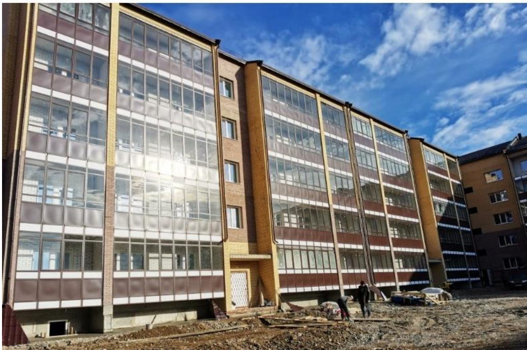
Рисунок 3.1.4 - Фотография объекта исследования по адресу ул. Генерала Тихонова 4.
