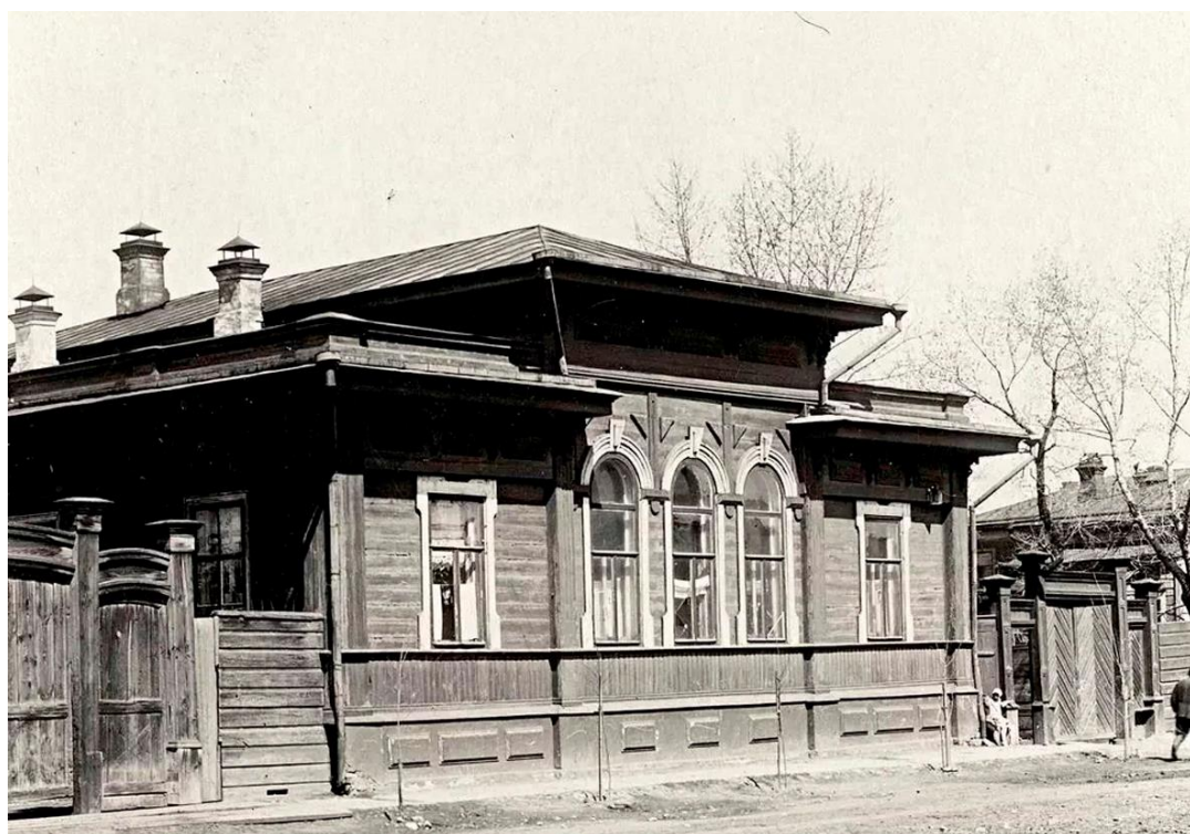
Рисунок Б.4 – Дом Фон-Эзерского, ул. Карла Маркса 24, фотография сделана с западной стороны, 1910-е гг. 100
