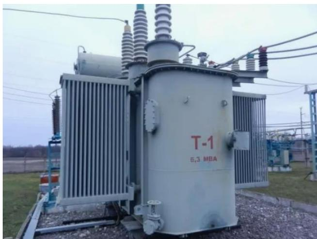
Рисунок 1.1 – Общий вид трансформатора 1Т подстанции ТМН-6300/110
