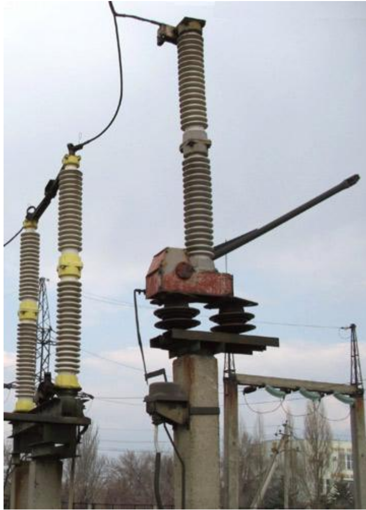
Рисунок 1.5 – короткозамыкатель типа КЗ-220
