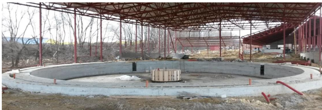
Рисунок 1.2 – Фотография строительства промышленной карусели
