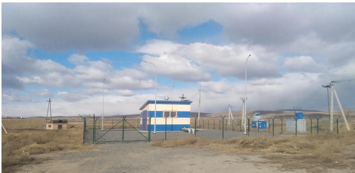
Рисунок 1 – Блочно-модульная повысительная насосная станция
