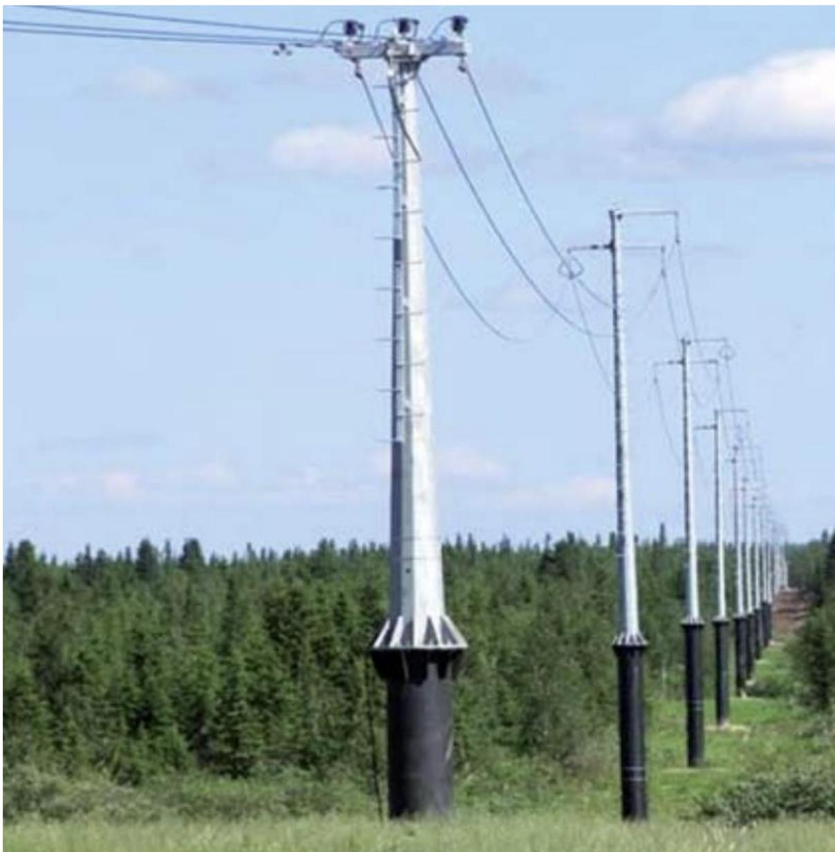
Рисунок 4 – Применение многогранных металлических опор при реконструкции воздушной линии 110 кВ
