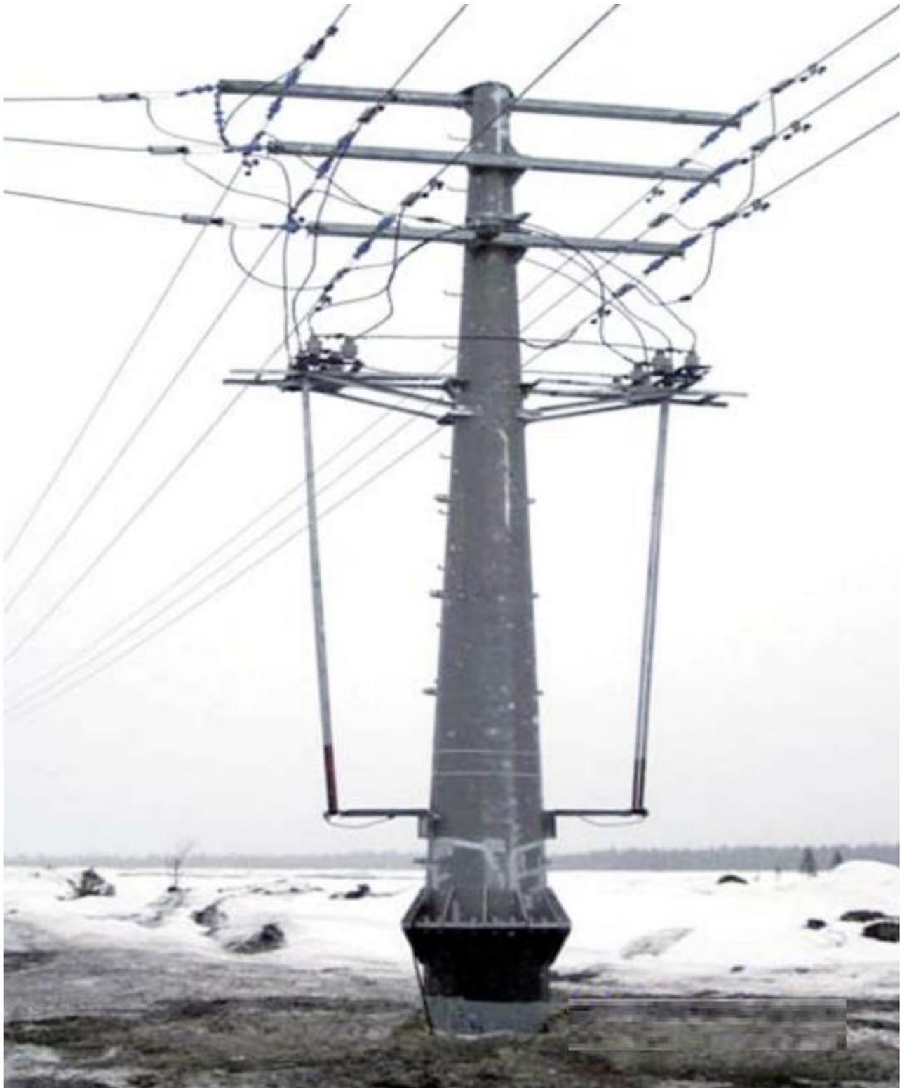
Рисунок 3 - Первая в Республике двухцепная ЛЭП высокого класса напряжения на многогранных металлических опорах
