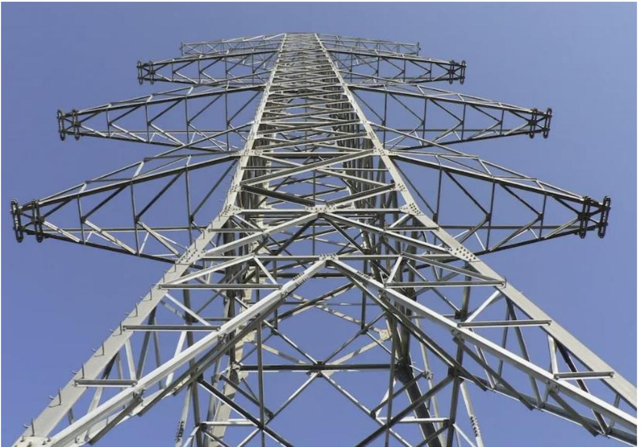
Рисунок 6 – Стальная решетчатая опора марки П220-2
