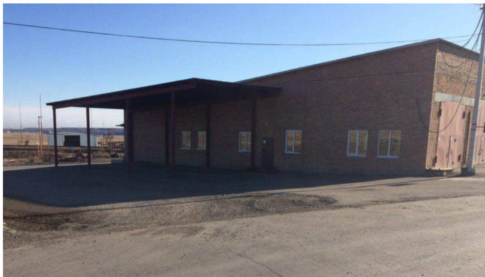
Рисунок 1.5 – Пункт контроля технического состояния
