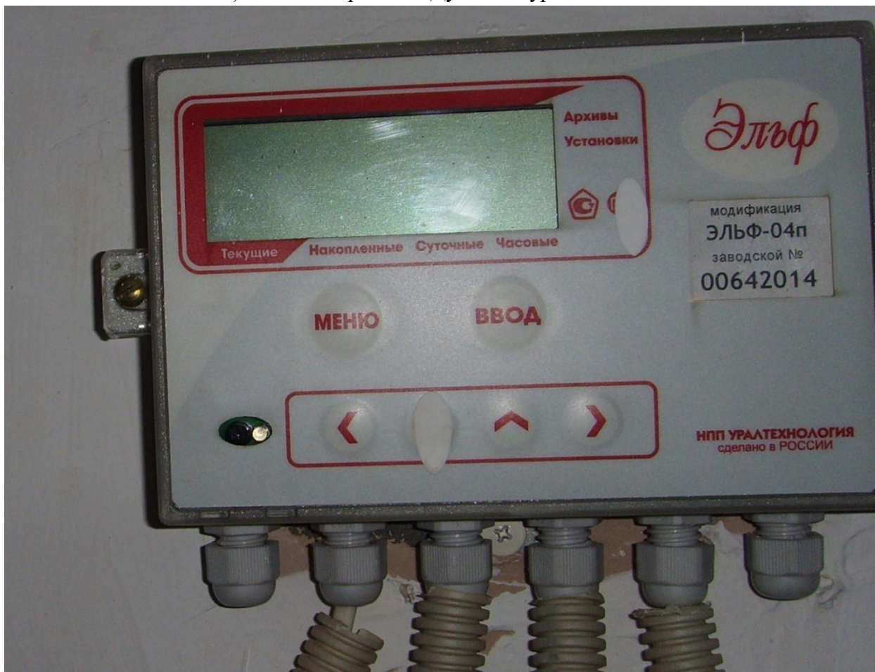
Б) Тепловычислитель Эльф-04п, заводской номер 00642014
