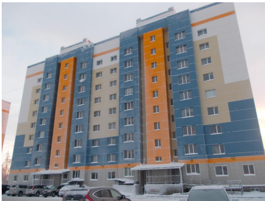
Рисунок 4.1 – Фотография исследуемого жилого здания
