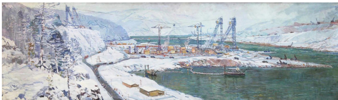
Рис. 6. Т.В. Ряннель. Строительство красноярской ГЭС. 1962 Fig. 6. T.V. Ryannel. Construction of the Krasnoyarsk HPP. 1962
