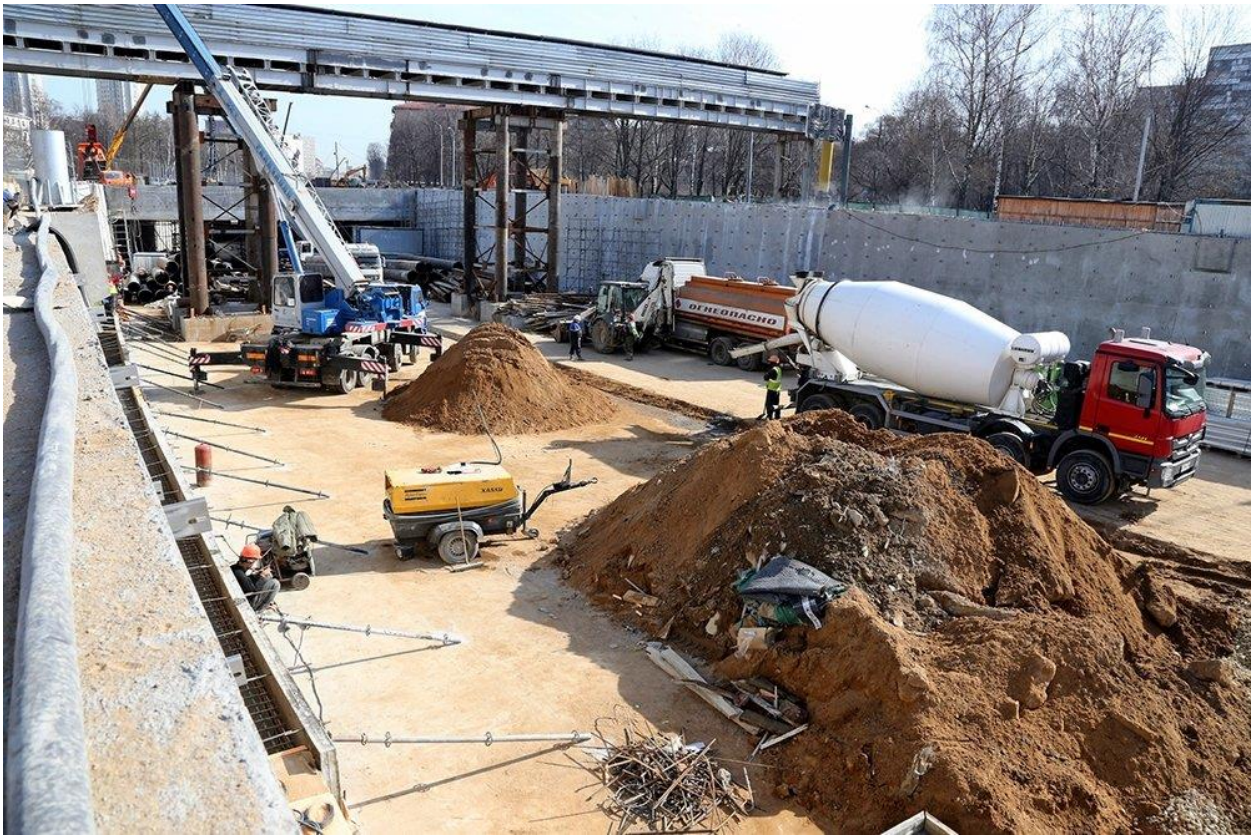
Рисунок 24 – Пример фотографии со стройплощадки
