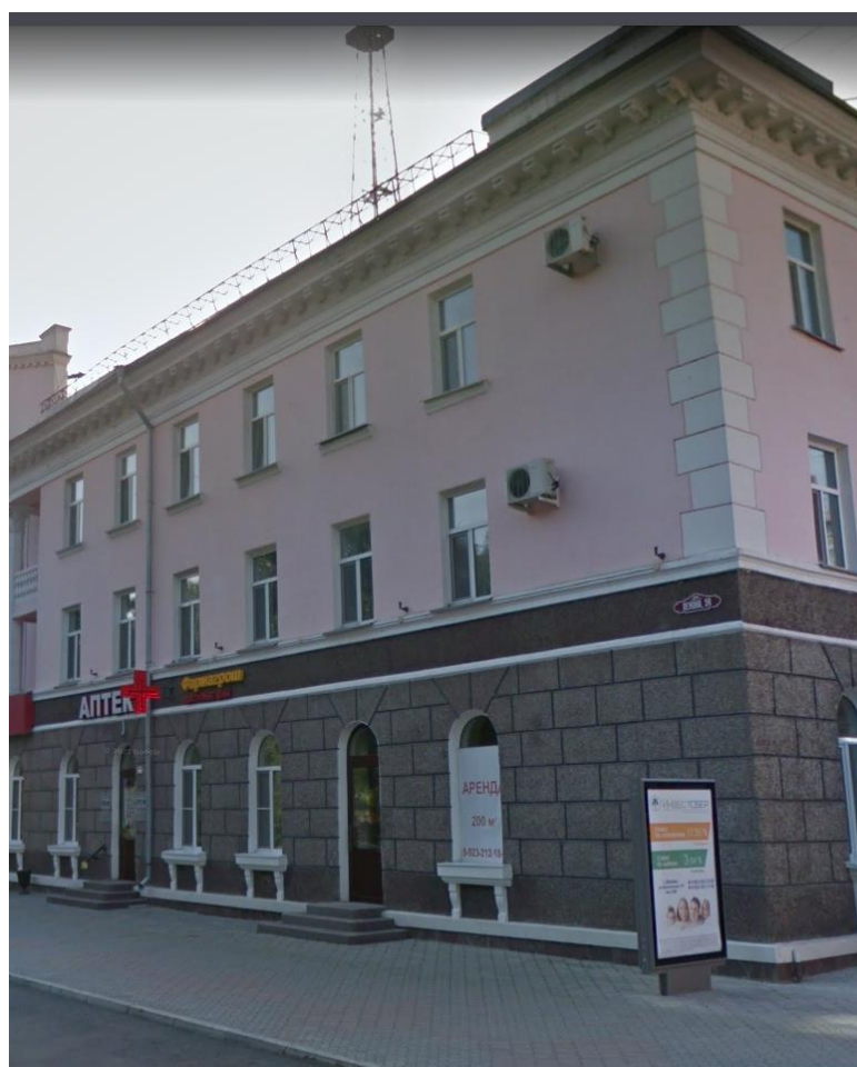
Рис. 1.6 – Северо-западный угол здания вдоль пр. Ленина
